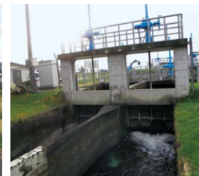
暗きょ方式取水口
